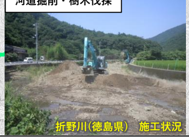
河道掘削・樹木伐採
