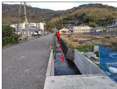
戎山排水区 (R5実施)
