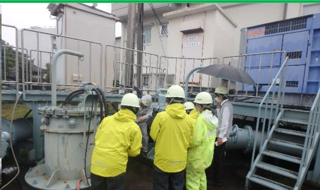
ポンプ操作訓練
