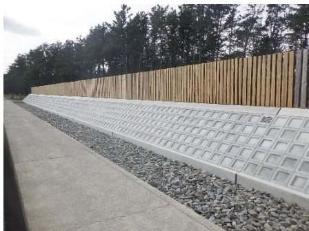
(山腹工(防潮工) : 海陽町大里松原地区)
