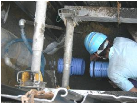
おすいかん 汚水管の工事 おすいかん 道路に汚水管をうめます。
