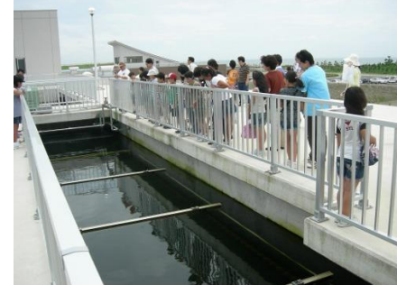
さいしゅう 最終ちんでん池とよばれる池 11～12ページの処理3(汚泥を しずめる処理)をしている池です。
