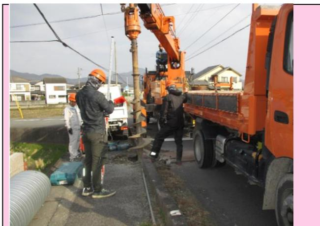
道路照明灯基礎工事のため、掘削中に既存水道管を破損し、1軒が断水となった。
