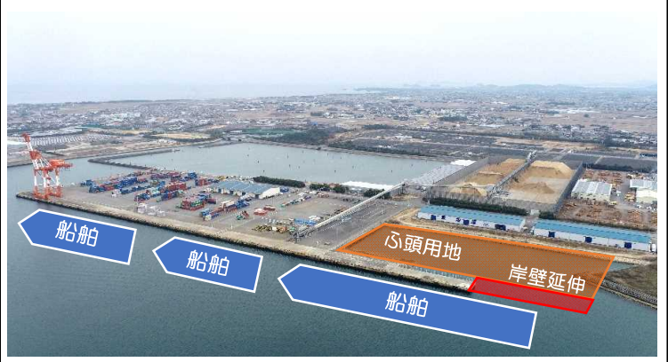
徳島小松島港赤石地区 港湾機能強化（船舶の大型化等に伴う岸壁延伸）の推進
