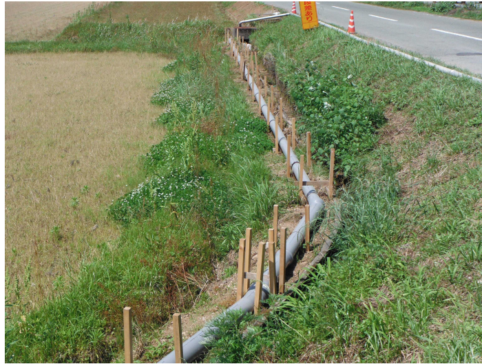
図4-5 仮廻し水路の状況
