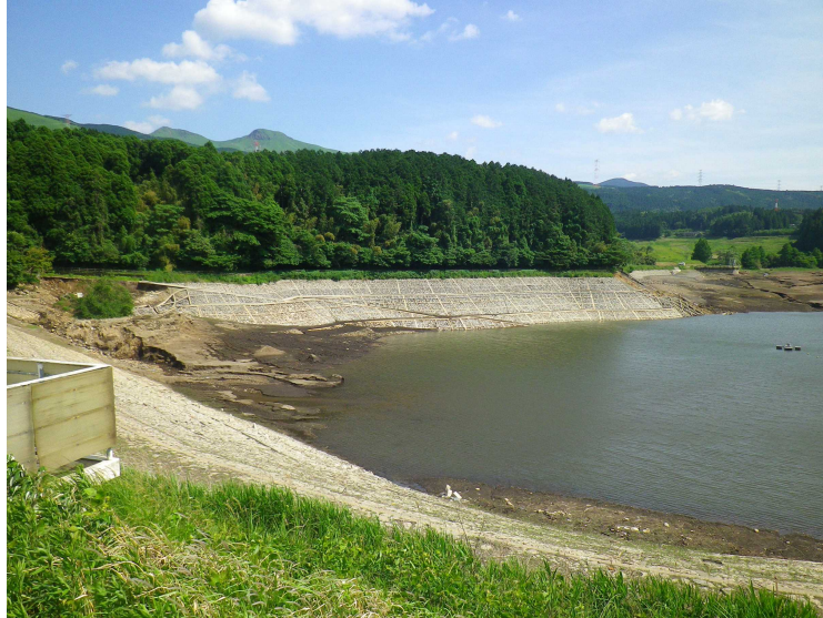
図4-7 緊急的に水位を下げたため池
