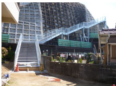
◆津波避難路の設置
