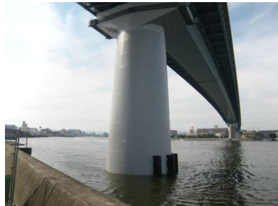
◆緊急輸送道路の橋梁耐震化
