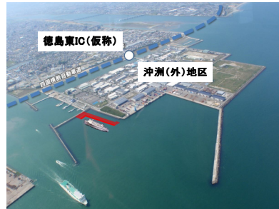
◆耐震強化岸壁の整備
