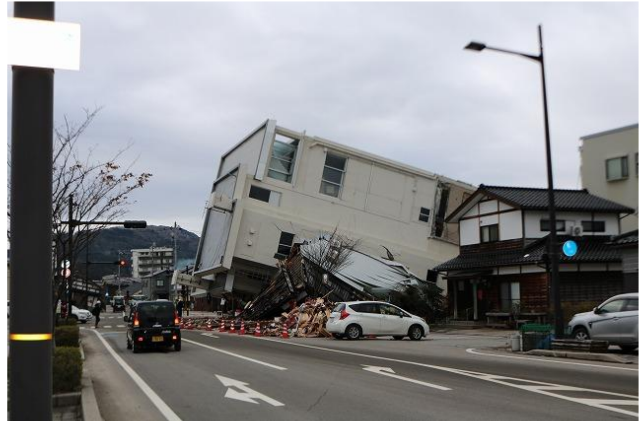
輪島市道 建物の倒壊状況②
