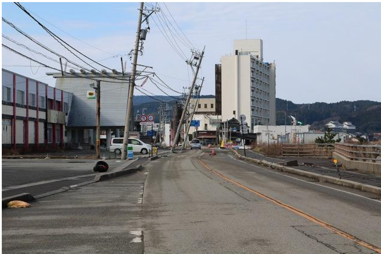
国道249号 電柱の倒壊状況①
