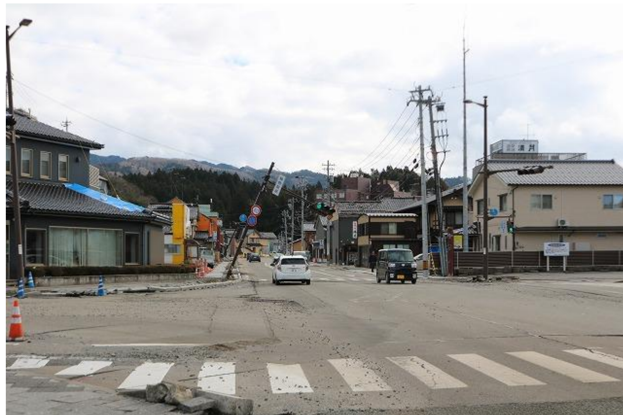
県道1号線 電柱の倒壊状況②
