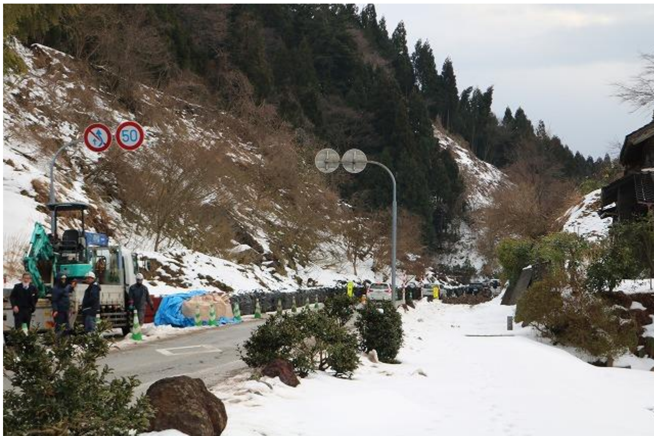
県道 1 号線 法面の崩壊状況①
