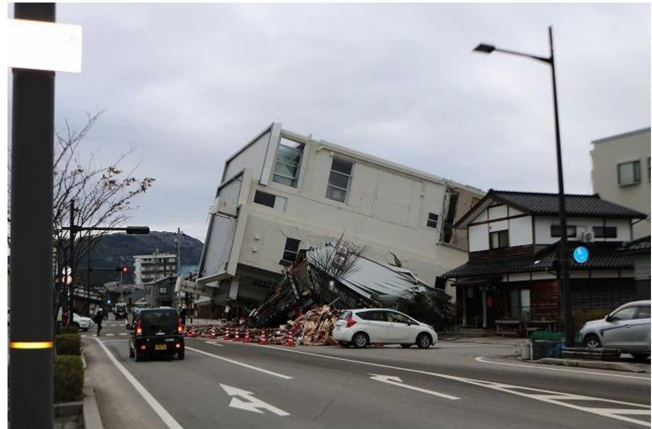
輪島市 建物（ビル）倒壊
