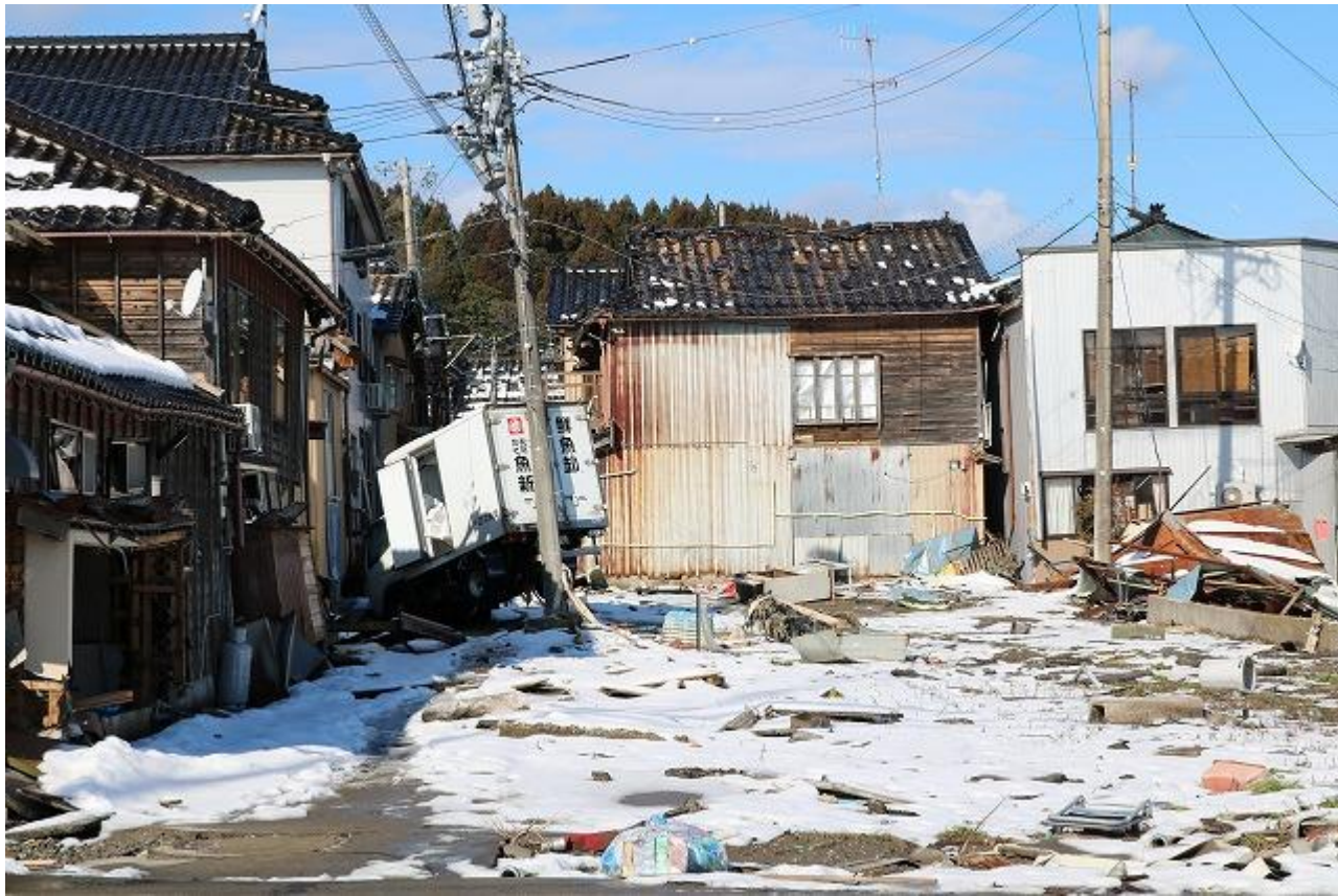
珠洲市 津波の被災状況①
