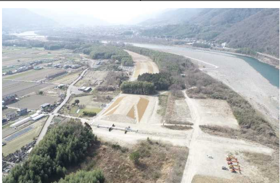
吉野川（加茂第二箇所） 堤防整備を促進
