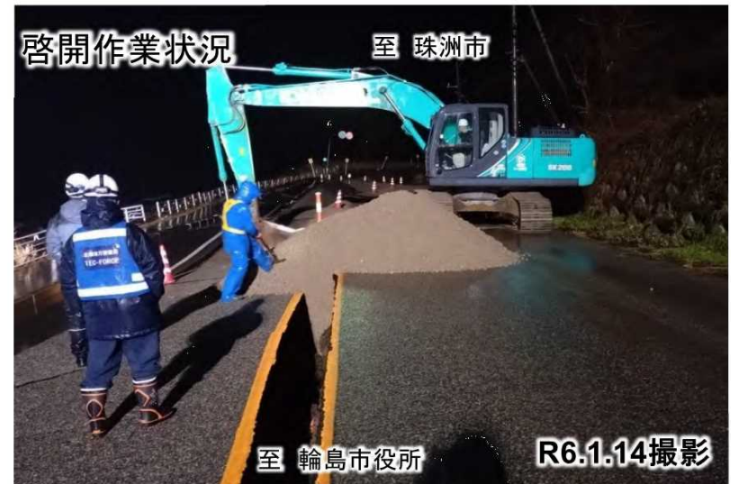
写真 道路の亀裂解消（石川県輪島市）
