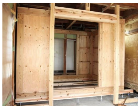
耐震シェルター
