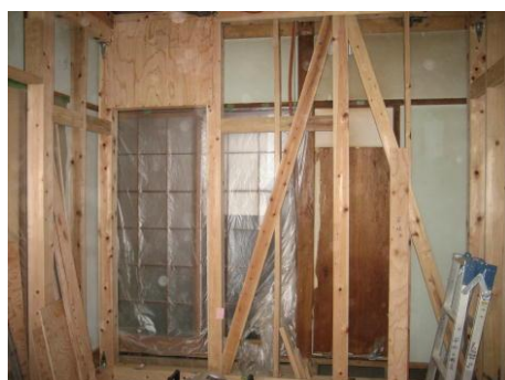
県産材による耐震改修
