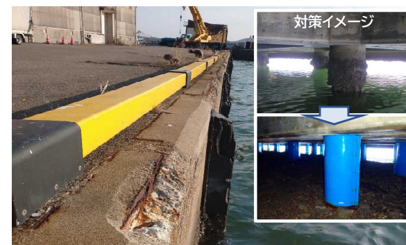
【徳島小松島港 沖洲地区 物揚場補修(徳島市)】
