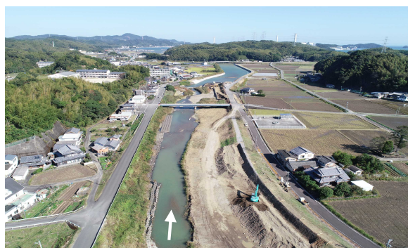
【福井川 堤防整備(阿南市)】
