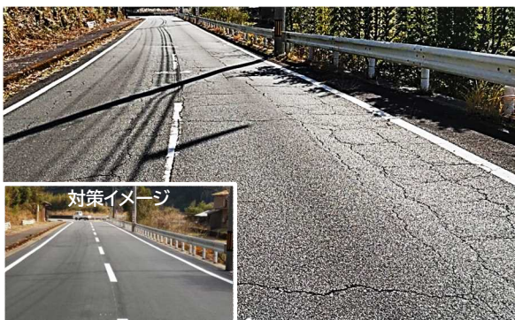
【久尾穴喰浦線 舗装補修(海陽町)】
