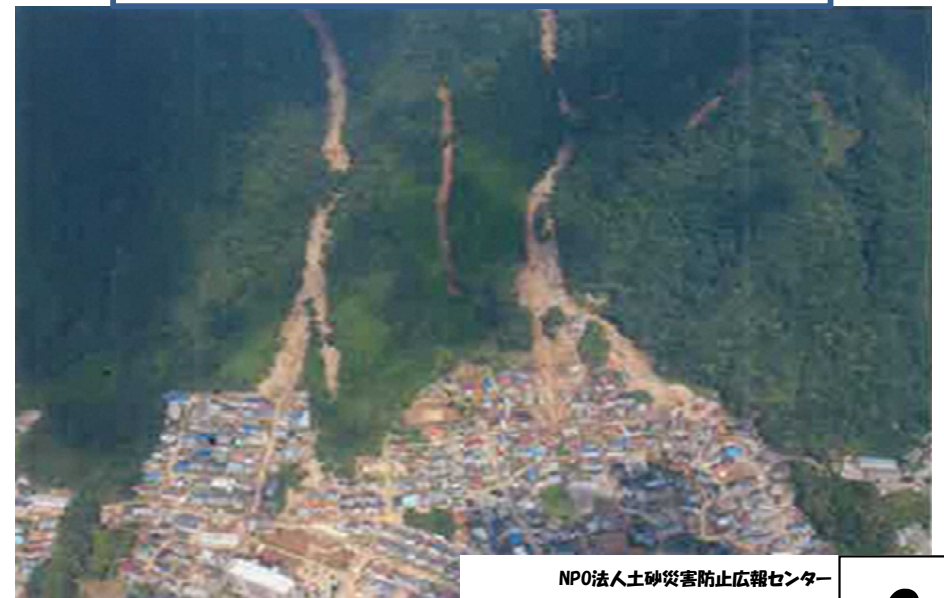
2014年 広島土砂災害(広島県広島市)
