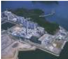
橘湾火力発電所
