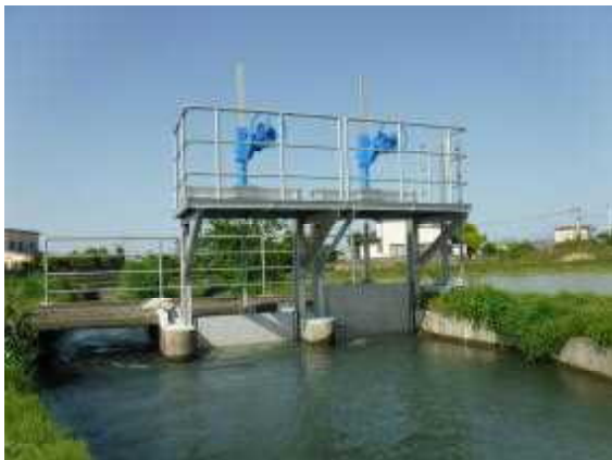
今津十二ヶ村分水樋門 (阿南市那賀川地区)
