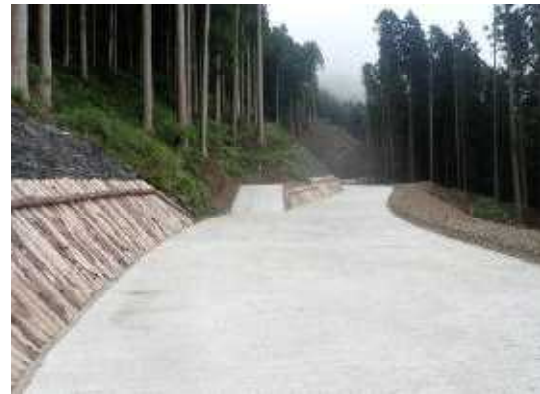
緊急輸送道路を補完する林道 （三好市 川崎国見山線）
