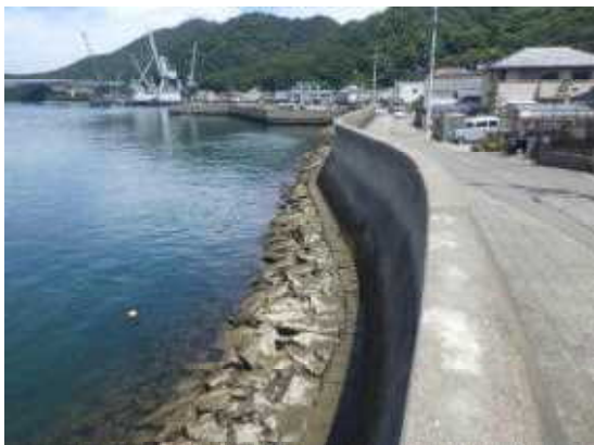
漁港海岸・護岸補強 （鳴門市土佐泊漁港海岸）整備前
