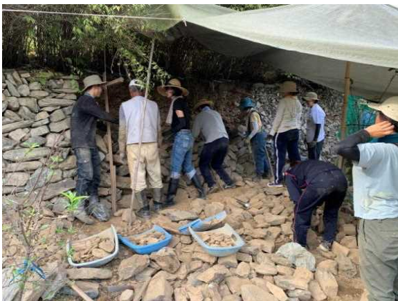
棚田の保全・活用 (棚田の石積み修復作業)
