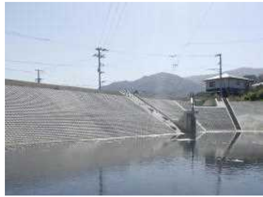
整備された農業用ため池 （三好市 花園池地区）
