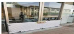
（止水板の設置）
