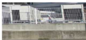
（電気設備の移設）
