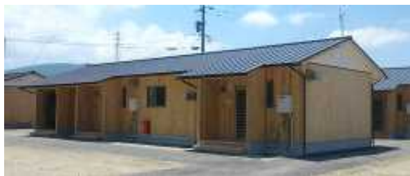
木造応急仮設住宅
