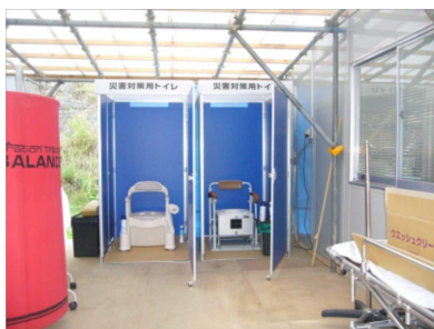
提供：特定非営利活動法人日本トイレ研究所 (東日本大震災における仮設診療所での簡易トイレ設置事例)
