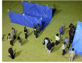
仮設テントの設営
