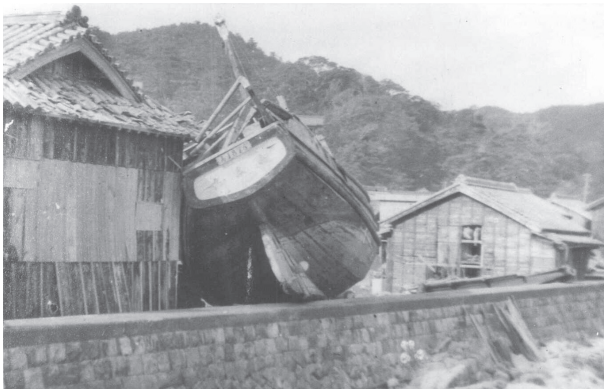
津波で堤防を乗り越えて民家へ突っ込んだ船(徳島新聞社提供)
