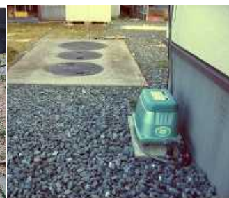
写真：設置完了
