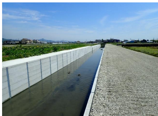
改修後の用水路(阿波市 古毛川排水路地区)
