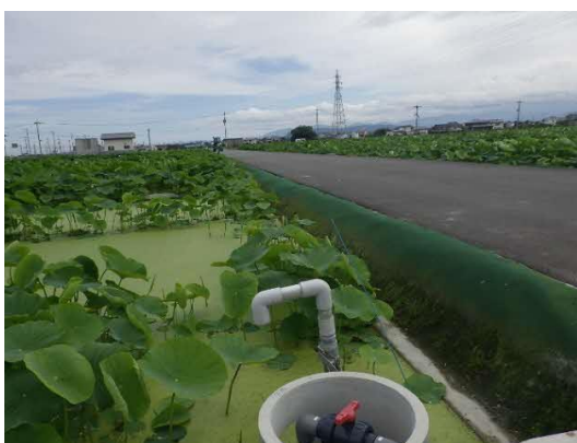
整備後の農道(鳴門市 大幸地区) (給水栓は国営附帯農地整備事業 大幸西で整備)
