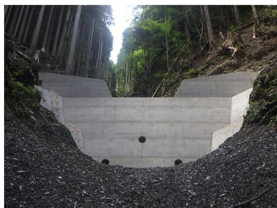
工事完了(治山ダム工)
