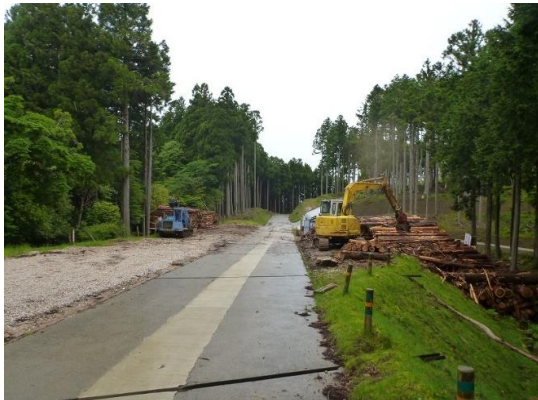
大川原旭丸線 大川原工区 (既設林道を利用した伐採・搬出状況)
