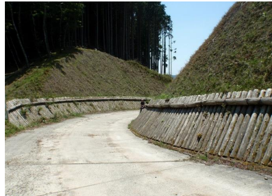
生実八重地線 八重地工区 (地形を利用した線形による開設)
