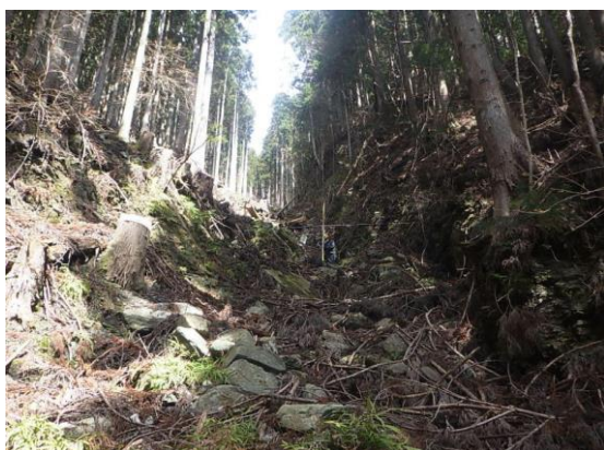
溪流に不安定な土砂が堆積
