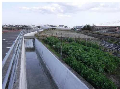
用水路補修(那賀川・小松島地区)
