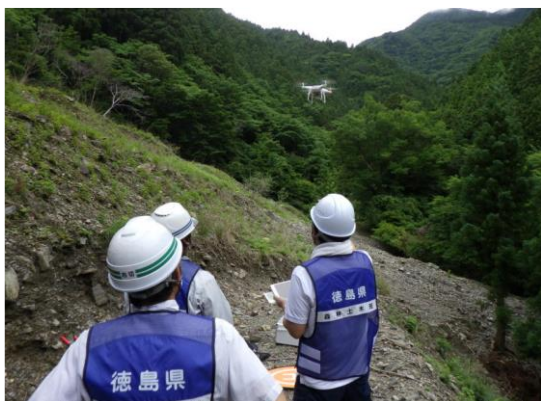
ドローンによる調査状況
