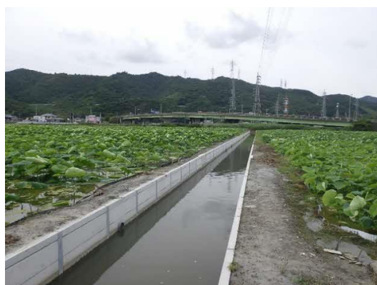
整備後の排水路(鳴門市 大幸地区)
