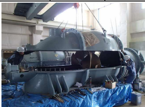
排水機 改修状況(小松島市 石見川地区)
