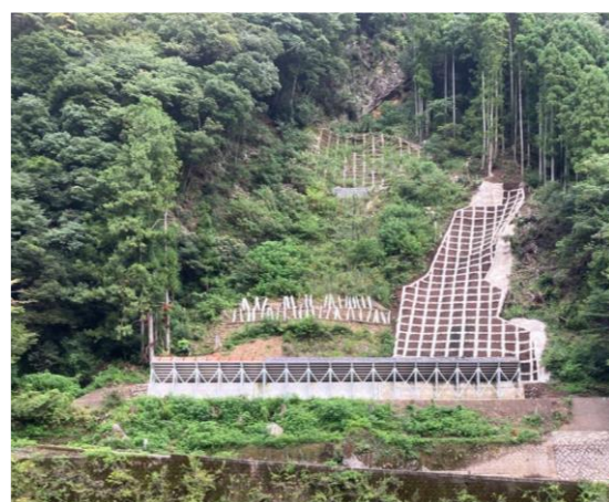
工事完了(山腹工)
