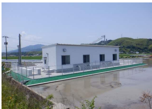
揚水機場(那賀川・小松島地区)
