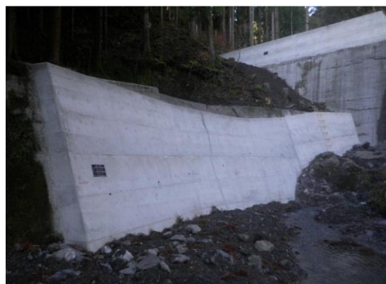
工事完了(護岸工)
