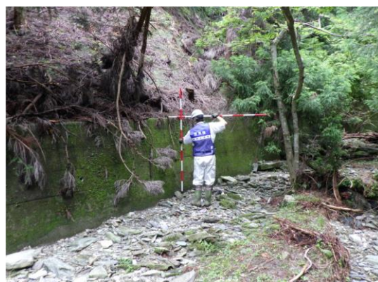
治山施設の点検状況
