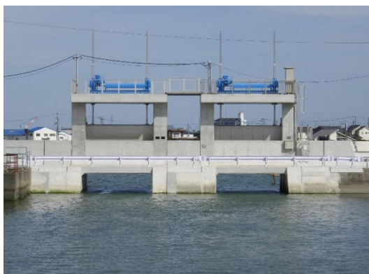
樋門改修完了(松茂町 喜来地区)
