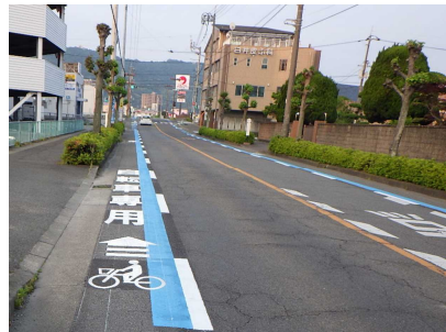
自転車専用通行帯整備状況 (徳島市道 北佐古・田宮・春日線)
