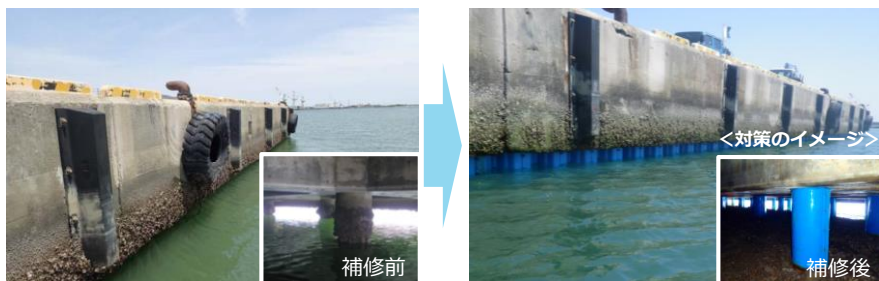
栗津港(里浦地区) 【岸壁の被覆防食工】
