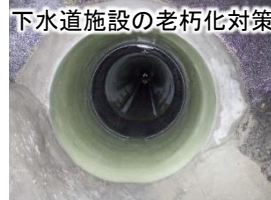
下水管渠の補強
