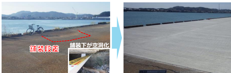
徳島小松島港(末広地区) 【物揚場の舗装補修・中詰固化処理】
