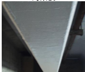
橋梁修繕事例 (橋梁下面の断面修復)
