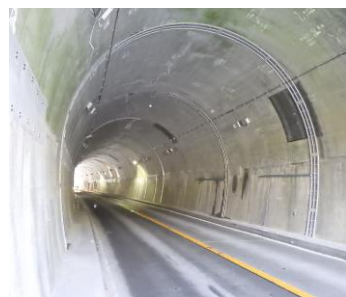
トンネル修繕事例 (漏水対策)
