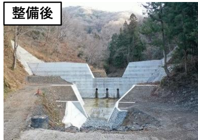
宇多谷 砂防堰堤 (美馬市)
