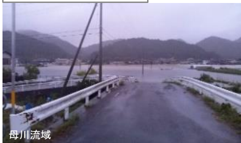
平成26年台風第12号浸水状況
