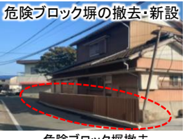
危険ブロック塀撤去フェンスの新設
