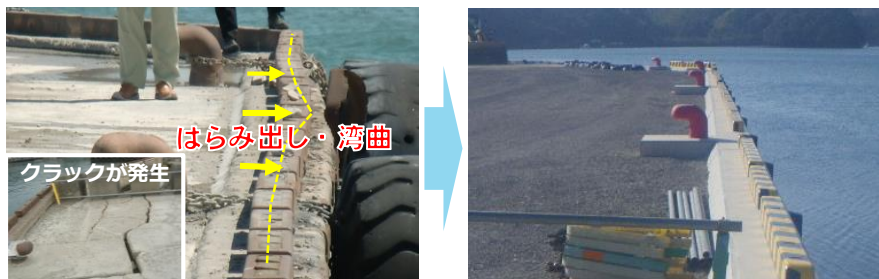
橘港(西浜地区) 【岸壁の補強】
