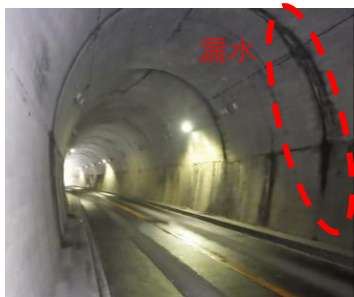
トンネル修繕事例 (漏水対策)
