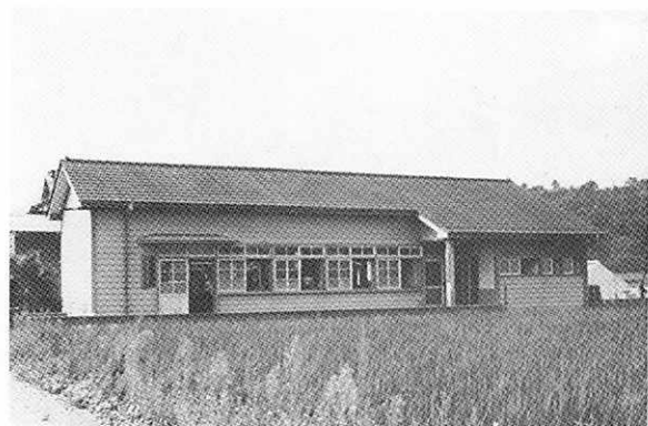
東からみた設立当時の本館（昭和32年）
