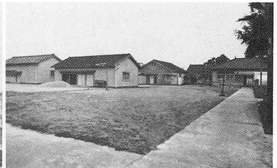
作業室と作業広場（共に昭和45年）
