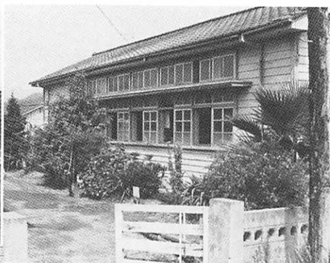
移転前の海南分場の裏門と本館（昭和40年）
