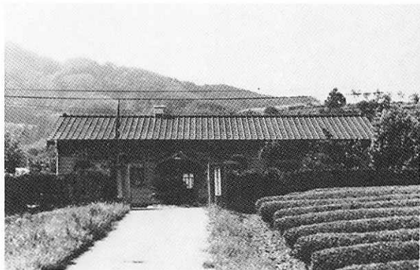
池田分場本館（昭和57年5月）
