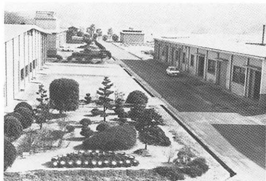
調査室および作業舎群
