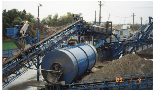
写真2-6-6 砂回収用ドラム式分級機による洗い砂処理
