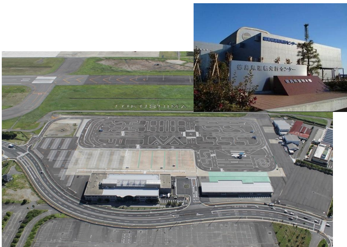
既存ストック有効活用で整備した徳島県運転免許センター（松茂町）
