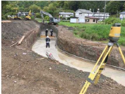
3次元設計データによる作業土工（床掘）を進めるMGバックホウとワンマン3次元測量
