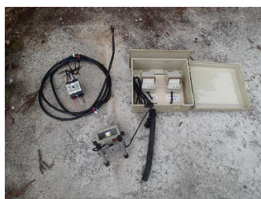
撤去した電力引込線及び計器
