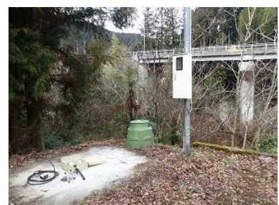
電力引込線及び計器撤去後
