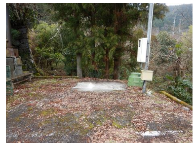
基礎及びフェンス撤去後
