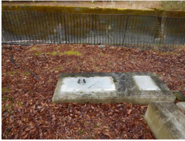
制御盤撤去後
