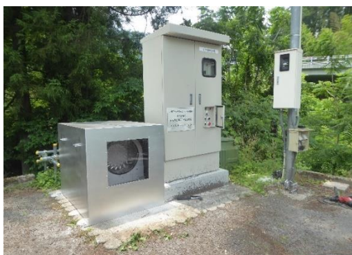
防音ボックス設置後の全景
