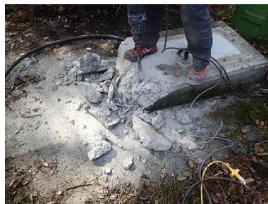
コンクリート基礎ハツリ
