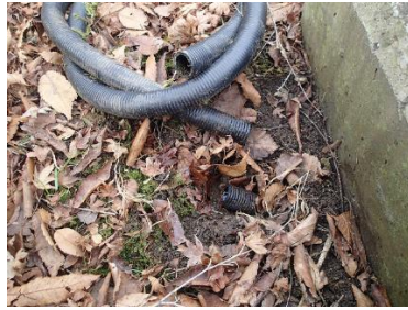
電線管の切断
