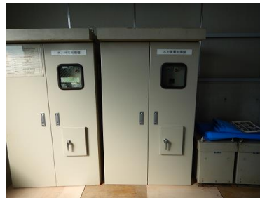
制御盤の搬入
