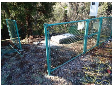
制御盤及び水車撤去後
