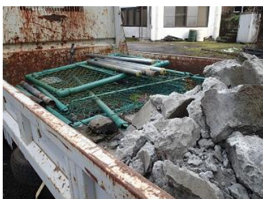
撤去したコンクリートとフェンス
