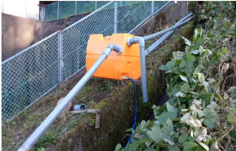
取水・沈砂タンクの設置(北川地区)500L
