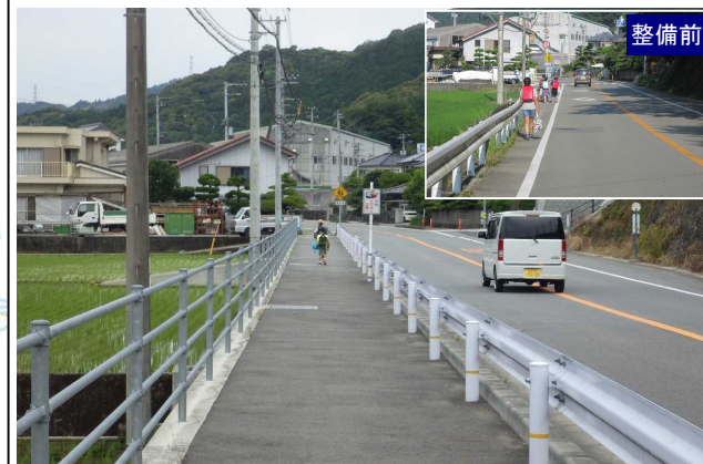
整備後 一般国道438号 芝生工区
