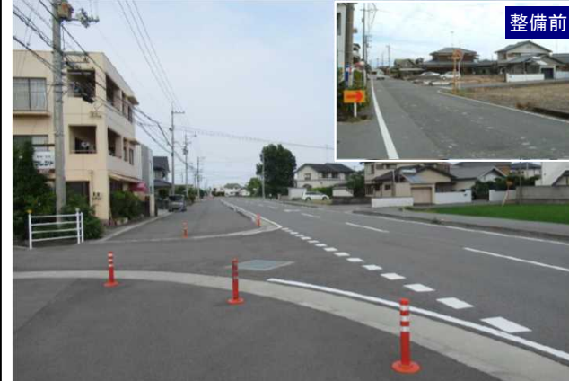
整備後 (一)坂野羽ノ浦線 中庄工区
