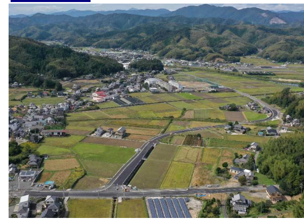
整備後 (主)阿南相生線 新野工区
