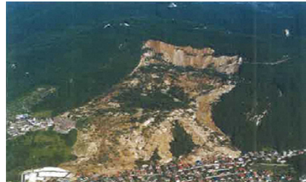
1995年 地附(ちづき)山地すべり(長野県長野市)
