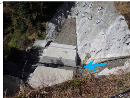
法面崩壊対策の状況
