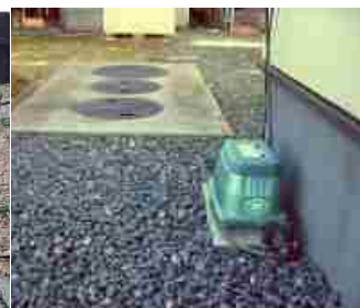
写真：設置完了
