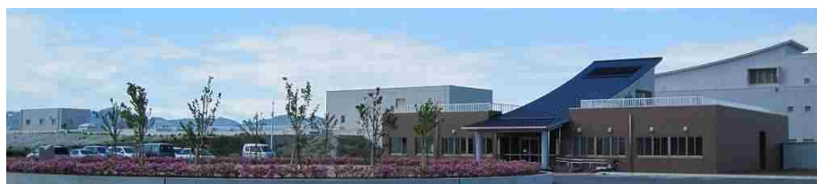
写真：旧吉野川浄化センター(アクアきらら月見ヶ丘) [徳島県]
