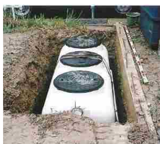
写真：設置状況
