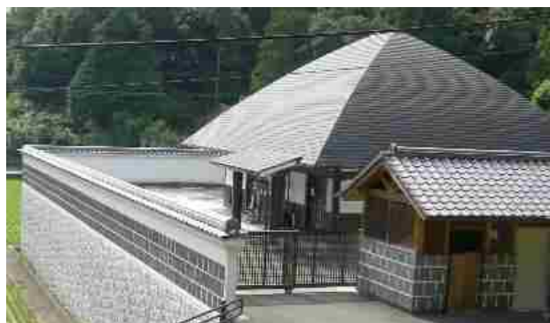
写真：高樋地区汚水処理場 [佐那河内村]
