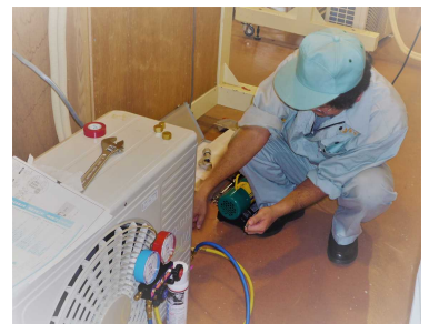
エアコン取付実習
