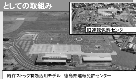
既存ストック有効活用モデル 徳島県運転免許センター
