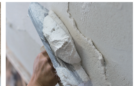
しっくい施工
