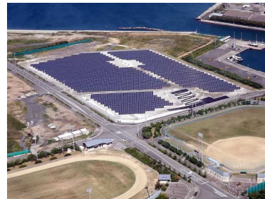
和田島太陽光発電所
