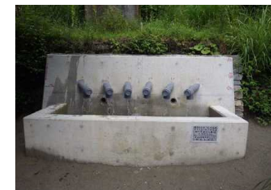
横ボーリング工
