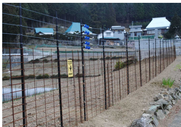
侵入防止柵（複合柵）
