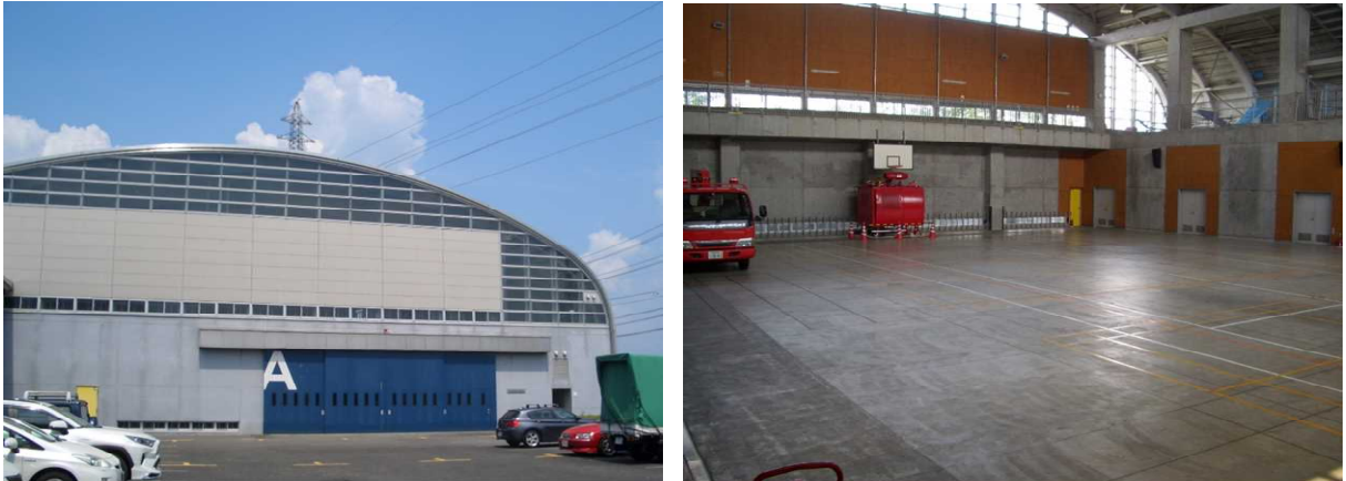
屋内集配施設
