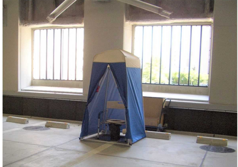
マンホールトイレ
