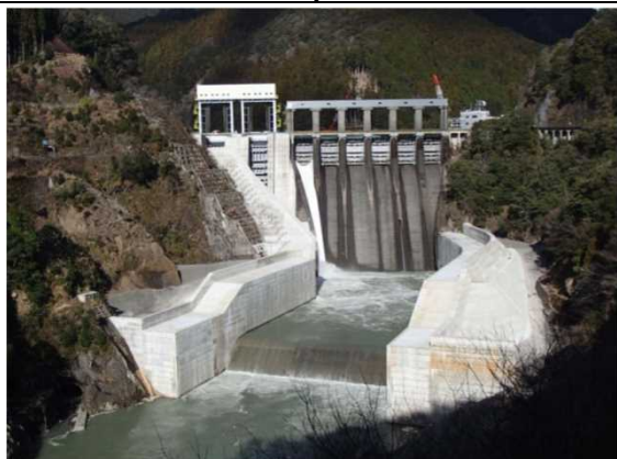
長安口ダム改造事業 新設洪水吐ゲート 令和元年度より運用開始
