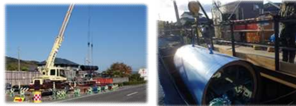
管路布設替工事の様子
