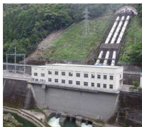
日野谷発電所
