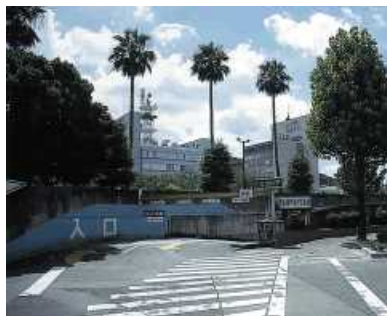
藍場町地下駐車場
