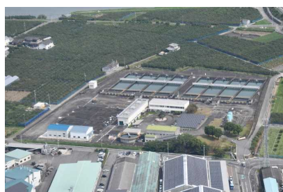
吉野川北岸工業用水道
