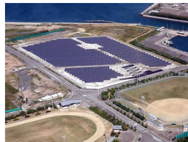
和田島太陽光発電所
