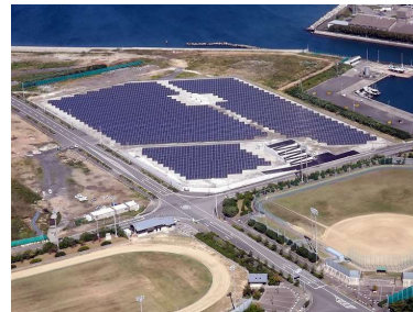
和田島太陽光発電所
