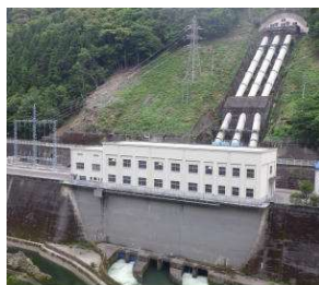
日野谷発電所
