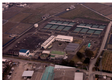
吉野川北岸工業用水道
