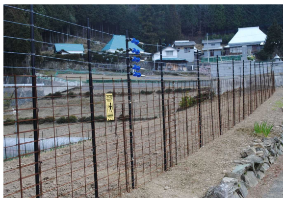
侵入防止柵（複合柵）
