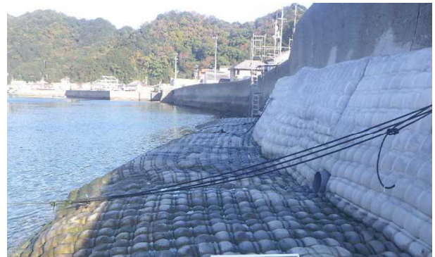
海岸整備（土佐泊漁港海岸・護岸）
