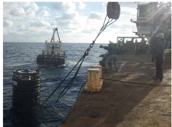
中層型浮魚礁の設置
