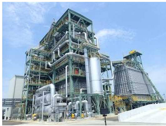
木質バイオマス発電施設
