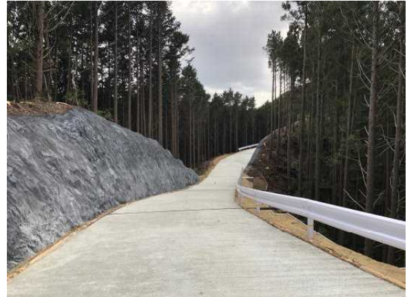
緊急輸送道路を補完する林道
