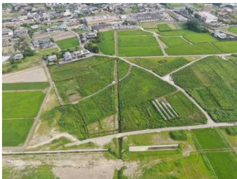
ほ場整備（沼田地区）着手前
