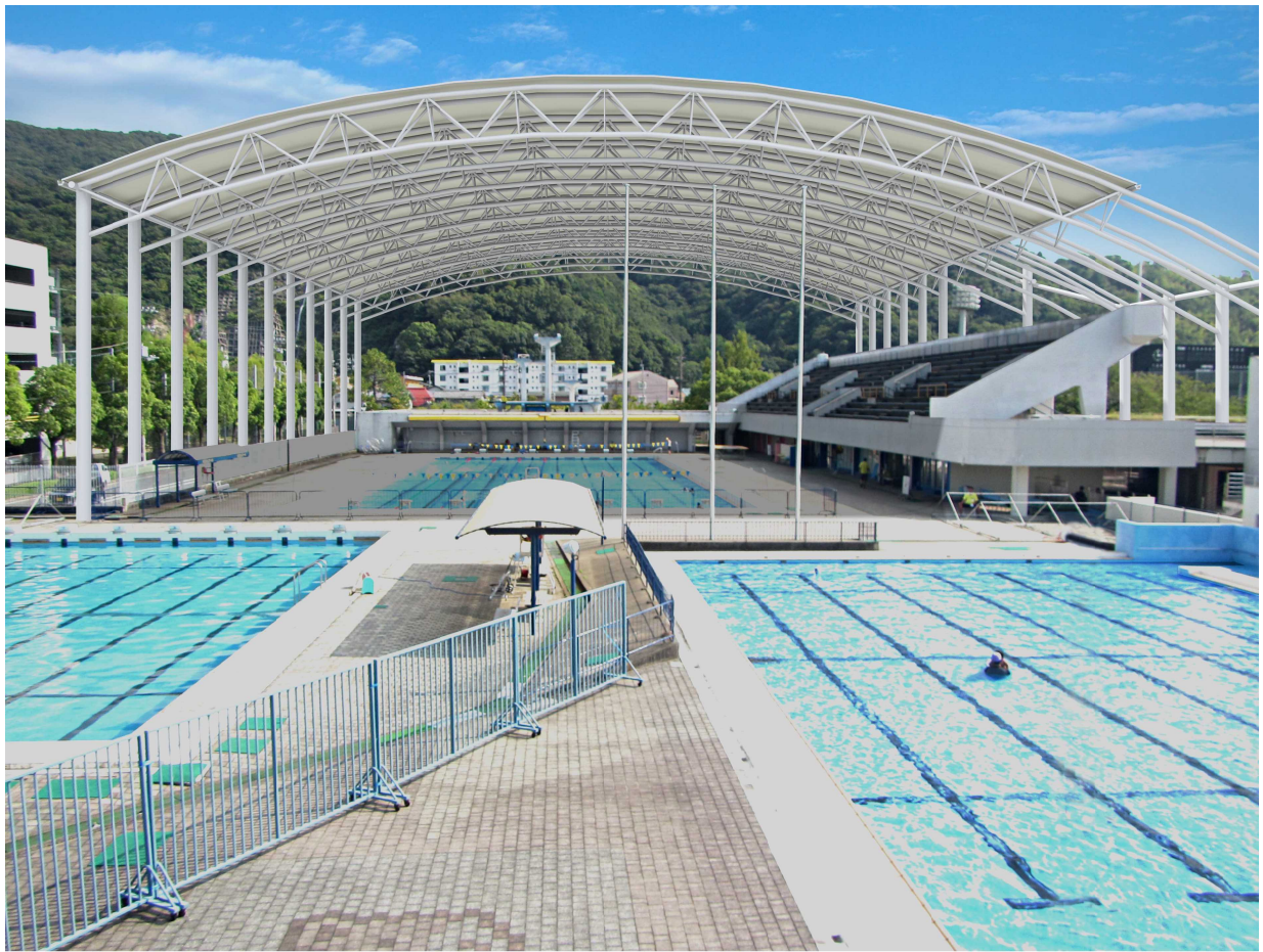
蔵本プール プール/スタンド全面
