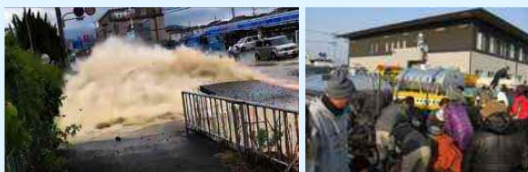
大阪北部地震 水道管の破裂
