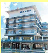
免震構造を採用し、H29に完成した県立海部病院
