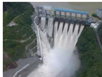
※長安ロダム改造事業（放流ゲート増設）
